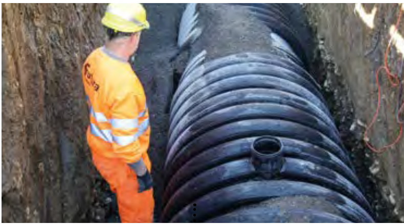
Intervento di saldatura 1200 - Belforte all'Isauro (PU)
