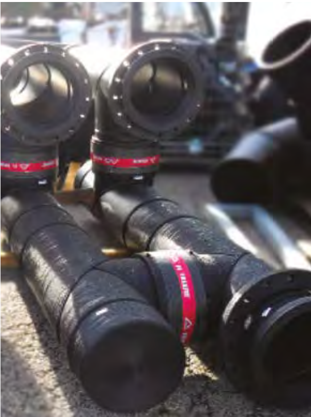
Collettore Ø400 PN10 SDR17 PE100 8620 Wetzikon (Svizzera)
