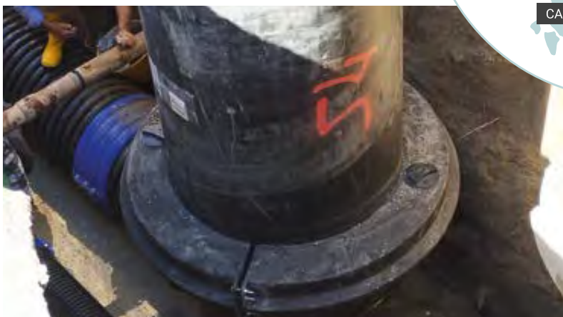
Pozzetti formati antifalda Ø1000 - Cagliari (CA)
