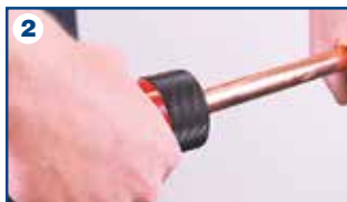
2 Sbavare esternamente il tubo
