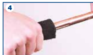
4 Pulire la superficie esterna del tubo
