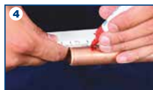
4 Marcatura di profondità
