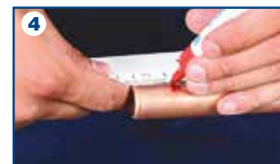
4 Marcatura di profondità
