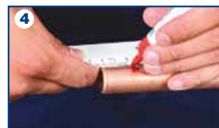
4 Marcatura profondità di giunzione
