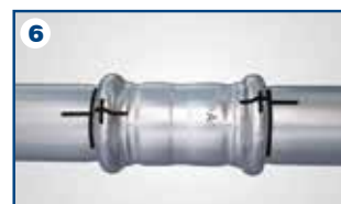
6 Marcare la giunzione completata
