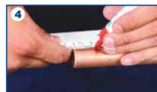
Marcatura di profondità
