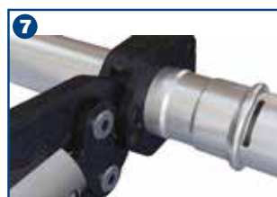
7 Pressare il raccordo
