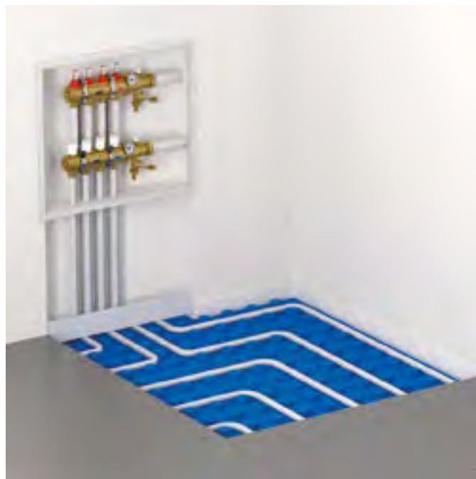
Impianto radiante realizzato con tubo multistrato Mixal
